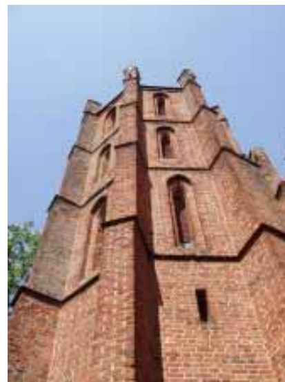
Foto 2. Wieża kościoła w Lembargu, ujęcie od pd.
