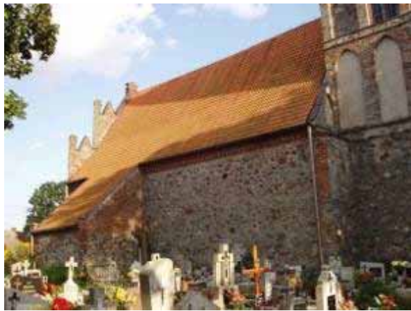
Foto 1. Pn. elewacja nawy kościoła w Dębowej Łące
