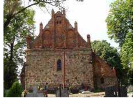
Foto 15. Harmonijna elewacja wsch. kościoła w Brudzawach.
