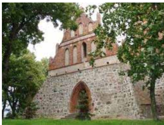
Foto 3. Zachodnia elewacja kościoła w Wabczu.
